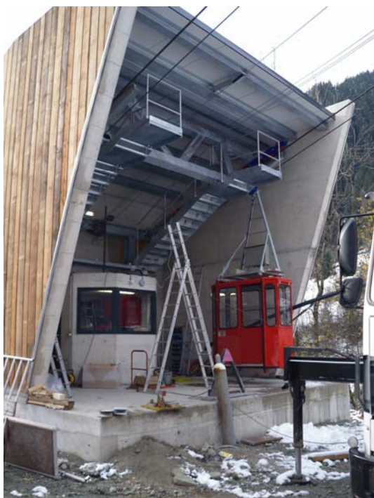
Nouvelle station inférieure du téléphérique
