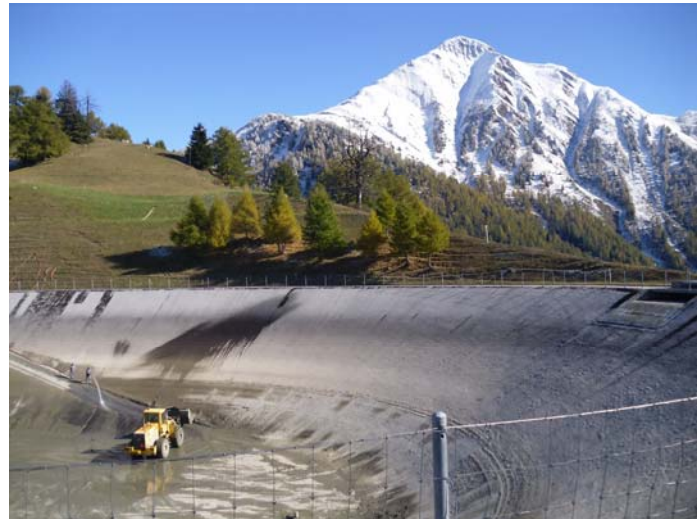
Ausbaggerung Becken Frid
