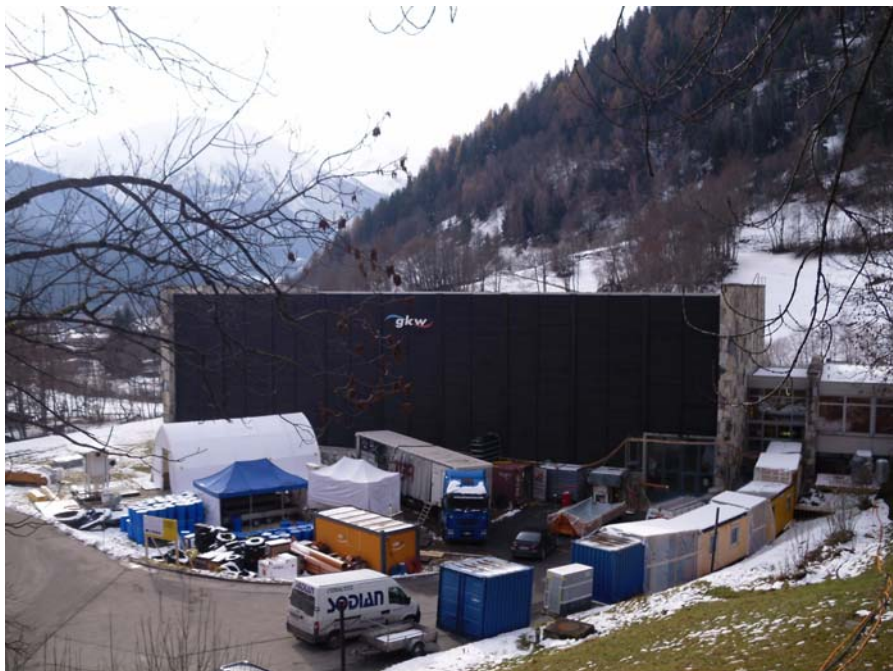
GWK III – Assainissement de la conduite forcée
