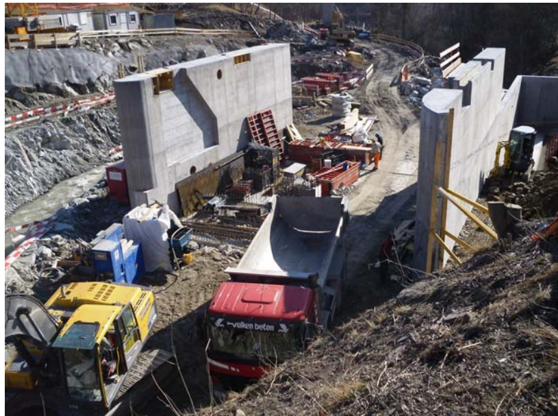
KW Wysswasser – Beginn der Arbeiten
